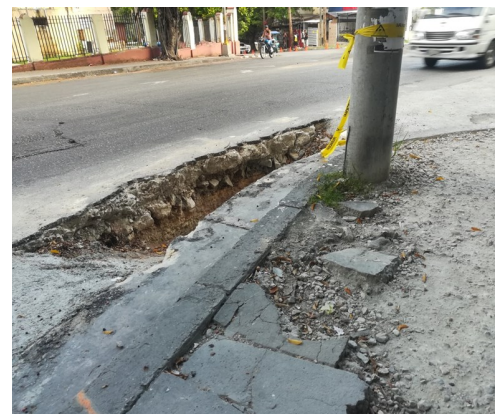
Hueco, calle 27 de Noviembre. Foto: ICLEP
