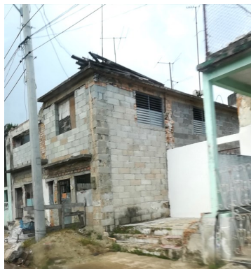
Construcción. Foto: ICLEP
