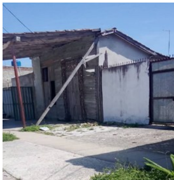
Vivienda. Foto ICLEP
