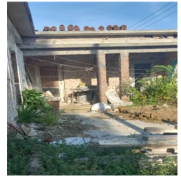
Construcción. Foto ICLEP
