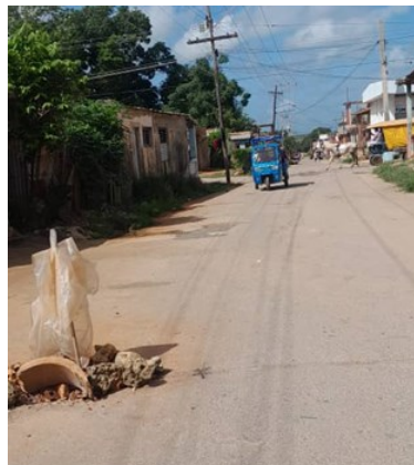
Hueco, calle 19. Foto: ICLEP
