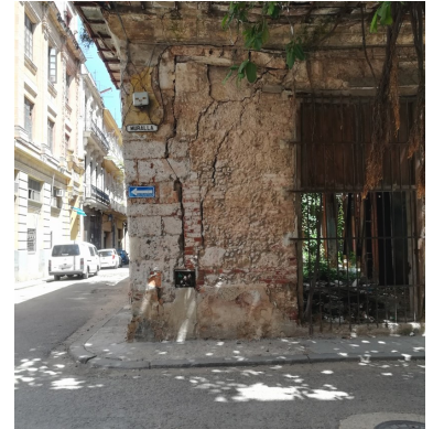
Inmueble, en calle Muralla entre Cuba y Aguiar. Foto: ICLEP
