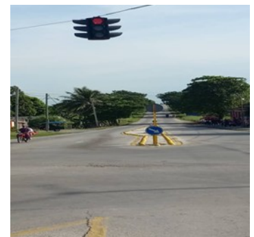
Carretera a Maleza. Foto ICLEP
