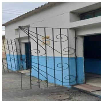
Bodega. Foto ICLEP
