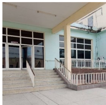
Hospital. Foto ICLEP
