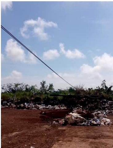
Poste caído en la avenida 26. Foto: ICLEP
