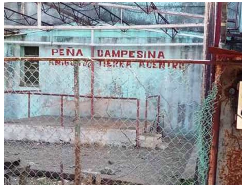
Local de “Amigos de tierra adentro”. Reparto Abraham Lincoln. Foto: ICLEP
