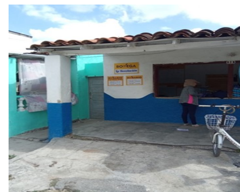
Bodega local. Foto ICLEP
