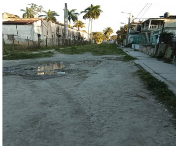
Vista exterior de la calle C, reparto Dolores. Foto: ICLEP
