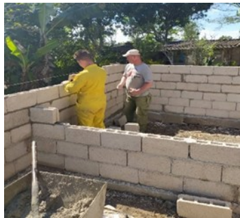
Construcción. Foto ICLEP
