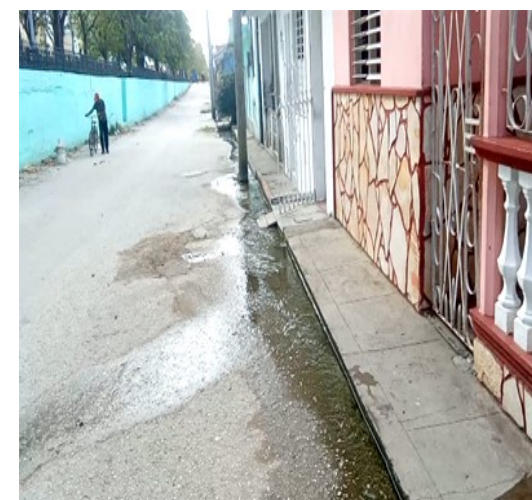
Salidero de la calle Máximo Gómez. Foto ICLEP
