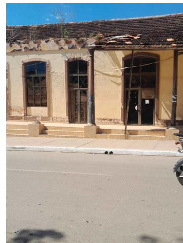
Antiguo Bazar, calle Central, municipio Artemisa. Foto: ICLEP
