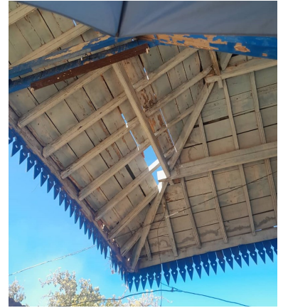
Techo de la terminal de trenes del municipio Artemisa. Foto: ICLEP
