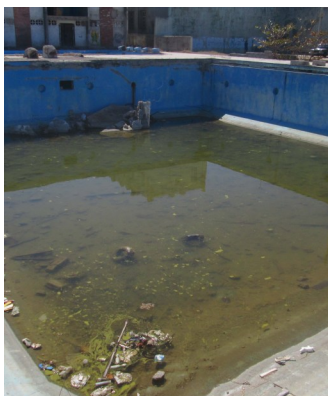
Área de piscinas del Estadio Martí. Foto: ICLEP
