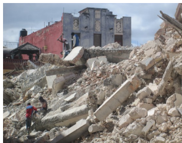
Existe un mercado informal con los derrumbes de la instalación Foto: ICLEP
