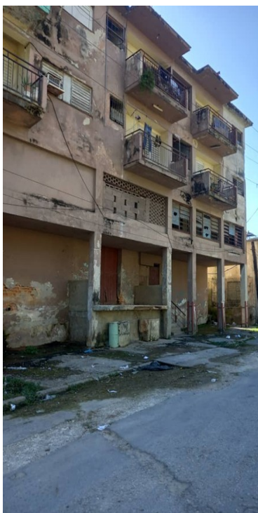
Edificio multifamiliar, Cerro. Foto: ICLEP
