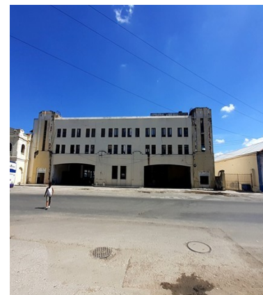
Unidad habitacional, calle Habana y Desamparados, municipio La Habana Vieja. Foto: ICLEP
