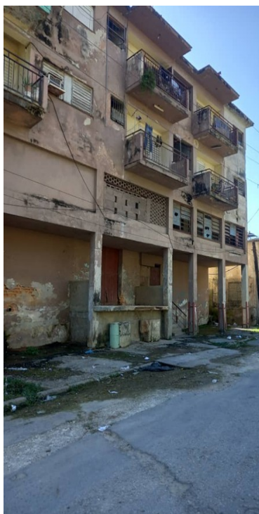
Edificio multifamiliar, Cerro. Foto: ICLEP
