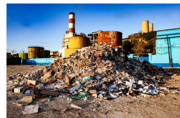
Basurero en Termoeléctrica de Tallapiedra, La Habana Vieja. Foto: ICLEP
