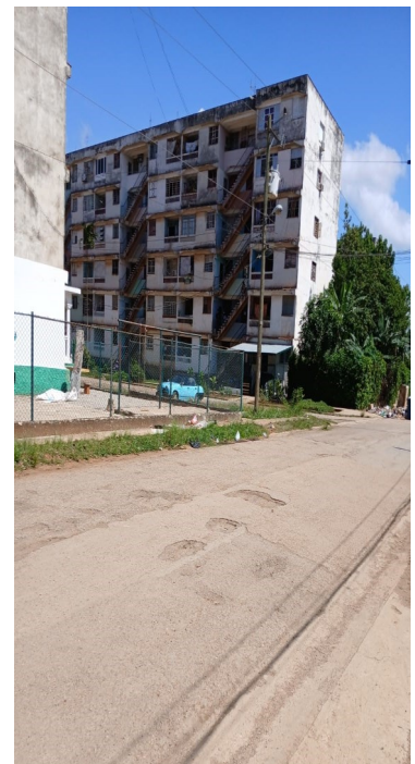
Edificio donde ocurrió el suicidio, reparto Abel Santamaría. Foto: ICLEP
