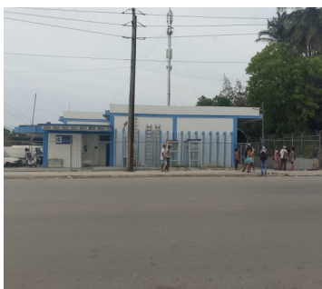
Oficina comercial de ETECSA, reparto La Cumbre, San Miguel del Padrón. Foto: ICLEP
