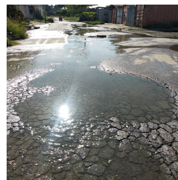
Barrio Los Patos. Foto ICLEP
