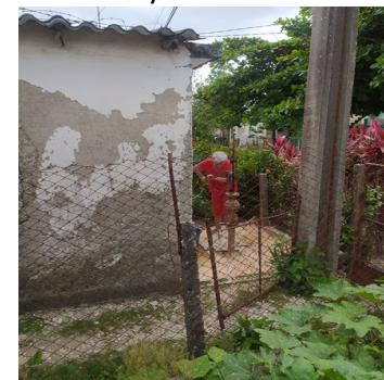
Reparto Camacho. Foto ICLEP
