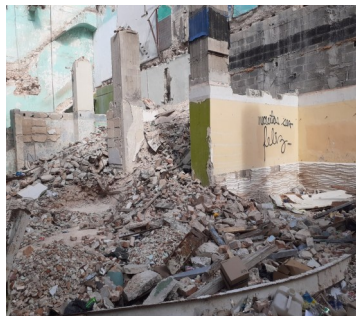
Inmueble en derrumbe en la entrada al Boulevard, Galiano y San Rafael. Foto: ICLEP
