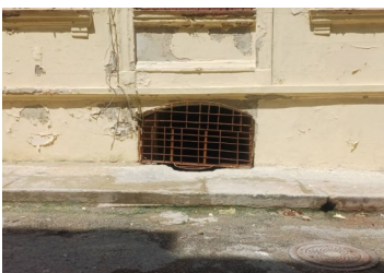
Entrada al sótano de calle Blanco. Foto: ICLEP
