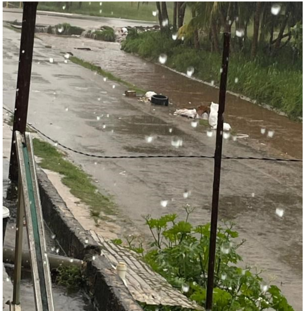
Canal de desagüe en la calle 58. Foto: ICLEP
