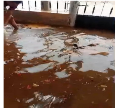
Casa de la calle Central, municipio Artemisa. Foto: ICLEP
