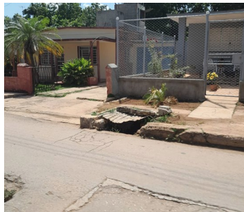
Registro de alcantarilla, calle Zayas, municipio Artemisa. Foto: ICLEP
