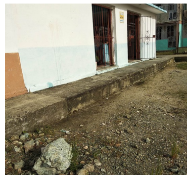
Bodega. Foto ICLEP
