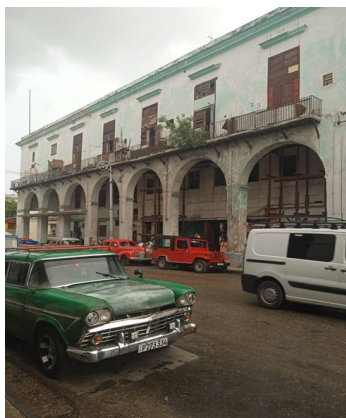
Edificio multifamiliar en la calle Galiano, entre Zanja y Dragones. Foto: ICLEP
