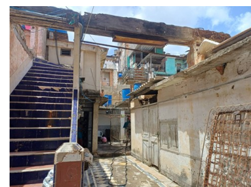
Interior del inmueble en Neptuno 1015. Foto: ICLEP
