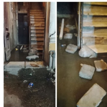
Presencia de una zanja y desagüe en la calle Amistad entre San Miguel y Neptuno. Foto: ICLEP
