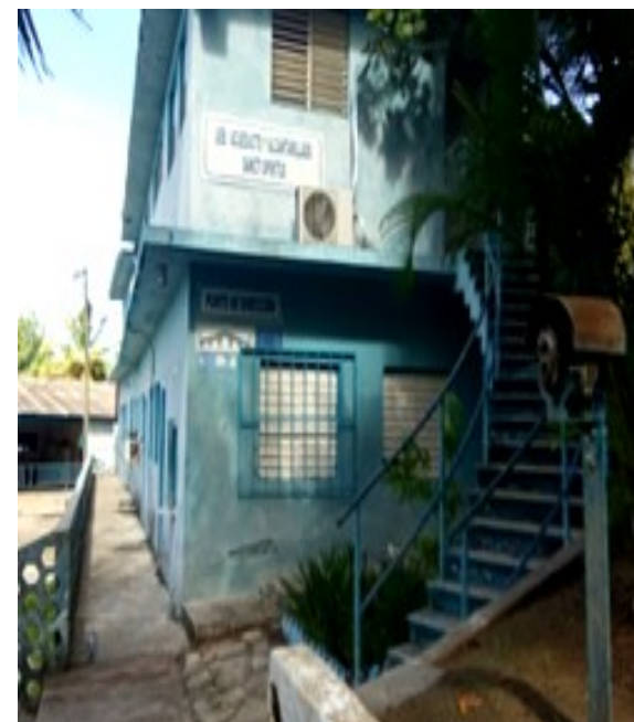
Acueducto Municipal. Foto ICLEP
