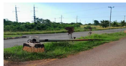
Poste del alumbrado público en la avenida Nueva de Artemisa. Foto: ICLEP
