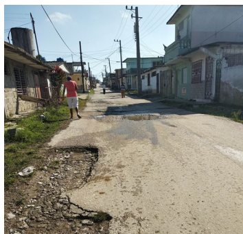
Reparto Camacho. Foto ICLEP
