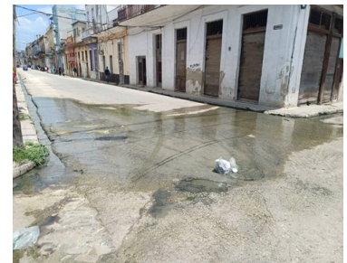
Aguas albañales en la esquina de Escobar y Benjumeda, Centro Habana. Foto: ICLEP
