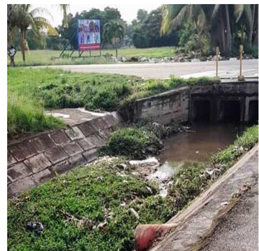
Canal de desagüe de la calle 58, municipio Artemisa. Foto: ICLEP
