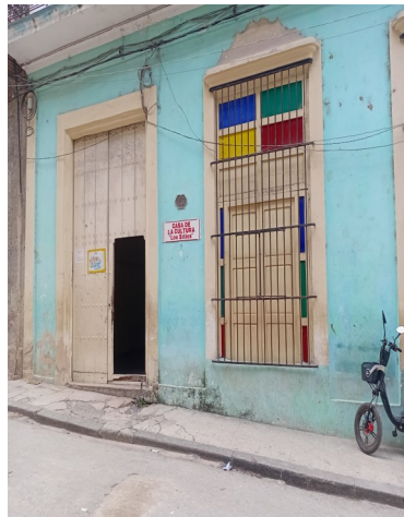
Fachada de la Casa de la Cultura de Los Sitios, Centro Habana. Foto: ICLEP
