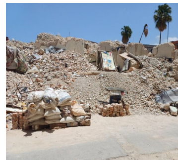
Ladrillos extraídos del antiguo edificio del ISDI. Foto: ICLEP
