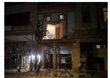
Edificio en la calle Galiano, Centro Habana. Foto: ICLEP
