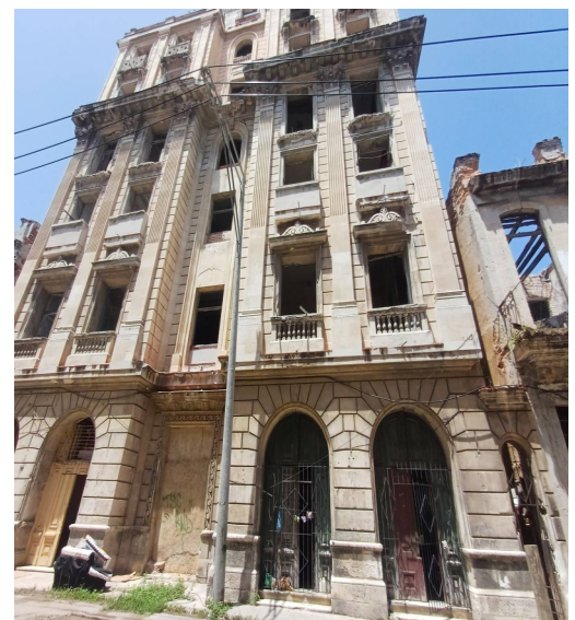
Edificio en Oquendo, entre San Miguel y San Rafael, Centro Habana. Foto: ICLEP
