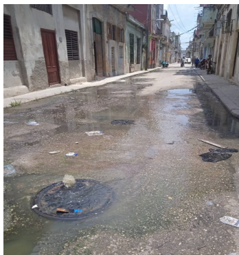
Aguas albañales en Centro Habana. Foto: ICLEP
