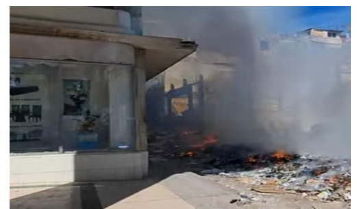
Incendio en Galiano y San Miguel, Centro Habana. Foto: ICLEP
