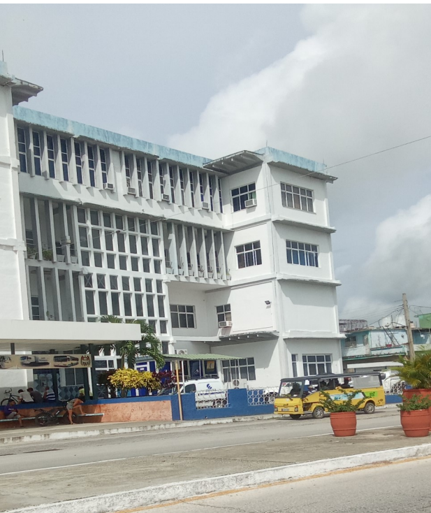
Empresa de Telecomunicaciones .(ETECSA). Fotos ICLEP
