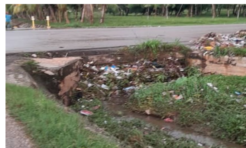
Canal de desagüe del callejón de Masó, municipio Artemisa. Foto: ICLEP
