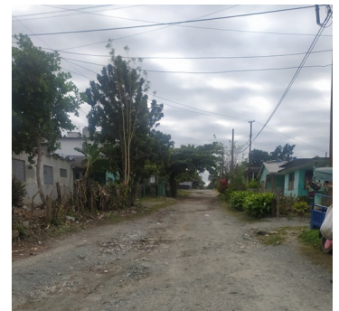
Barrio Los Patos. Foto ICLEP
