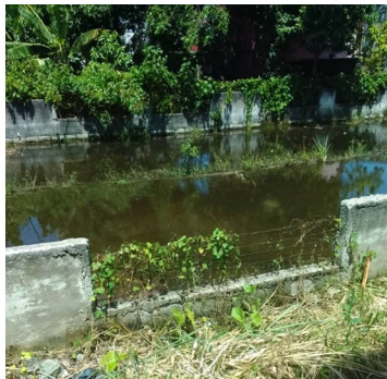
Cisterna comunitaria. Foto ICLEP
