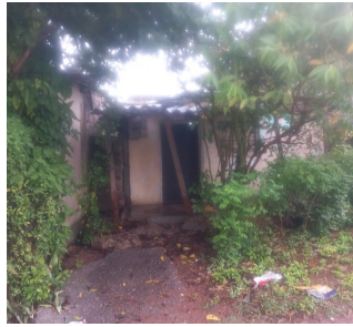
Vivienda de Asdrúbal Mojena, Romerillo. Foto: ICLEP
