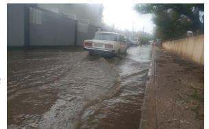
Calle 186 en Santa Fe, inundada por falta de drenaje. Foto: ICLEP
